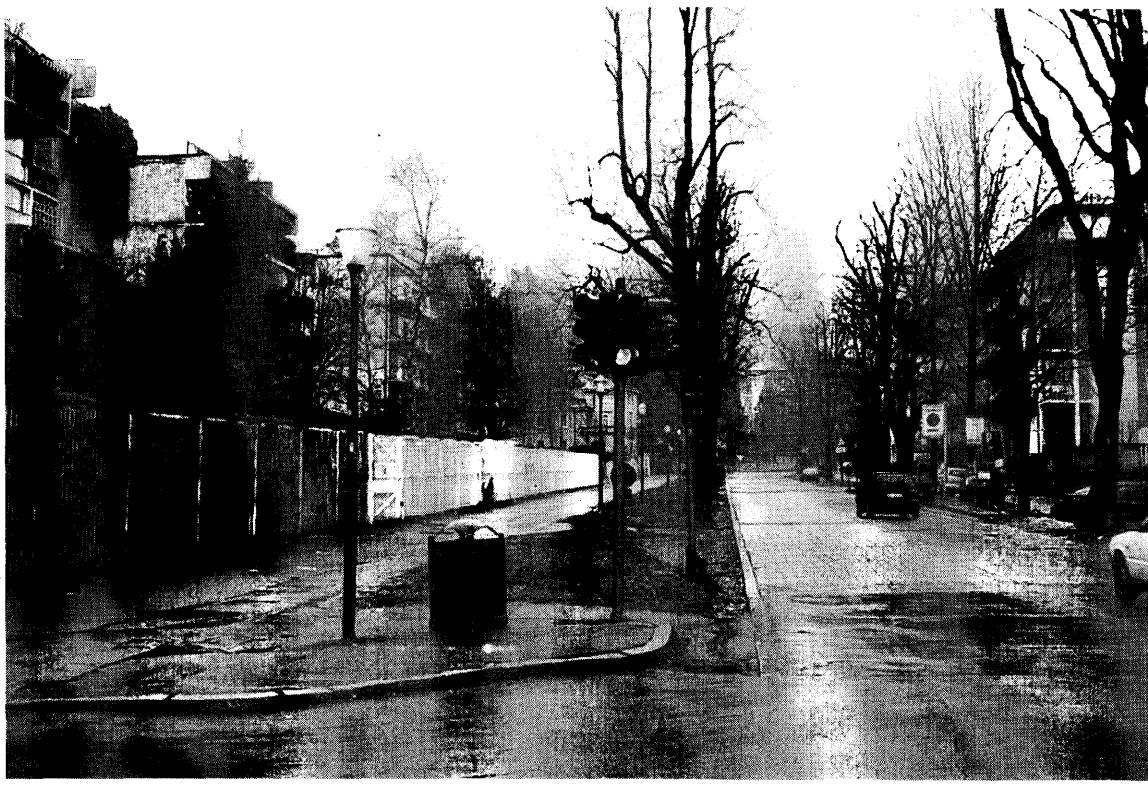
I lavori interesseranno inizialmente il tratto di strada che va da via Botta alla galleria Conca d'Oro (foto Bedoli)
