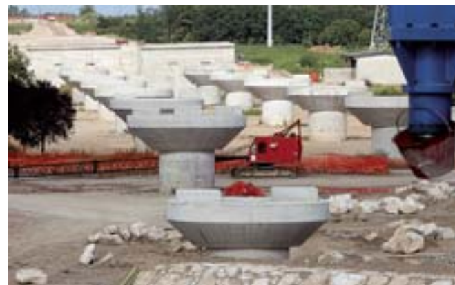
Pulizia Un cantiere della Brebemi: vi lavorano solo aziende verificate
