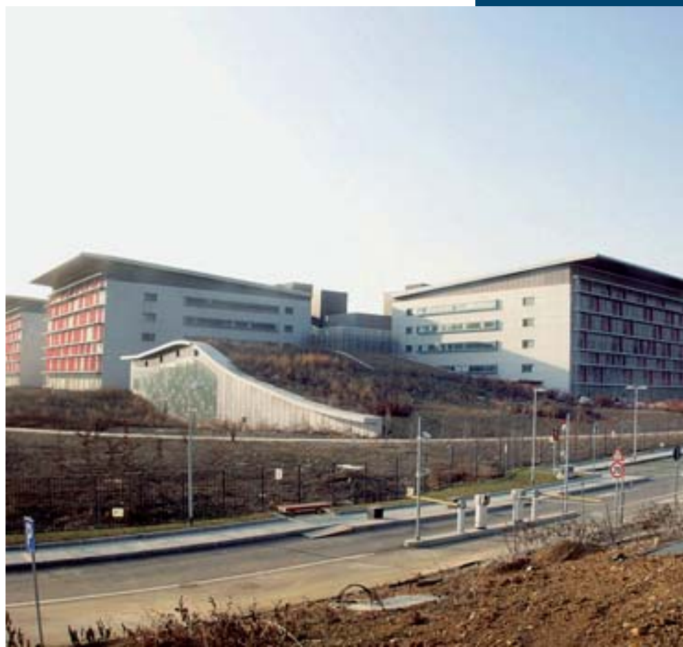
Il nuovo ospedale di Bergamo e l'ingresso da via King
