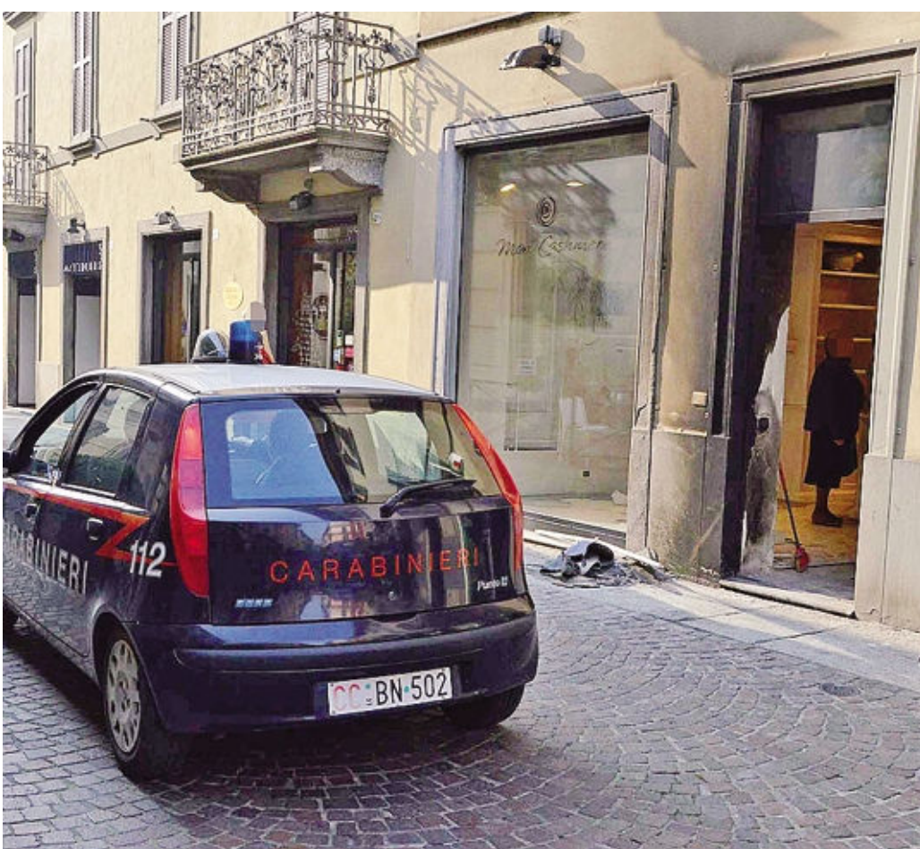
Il negozio «Mon Cashmere» di via Roma a Treviglio, danneggiato da un incendio doloso il 30 ottobre
